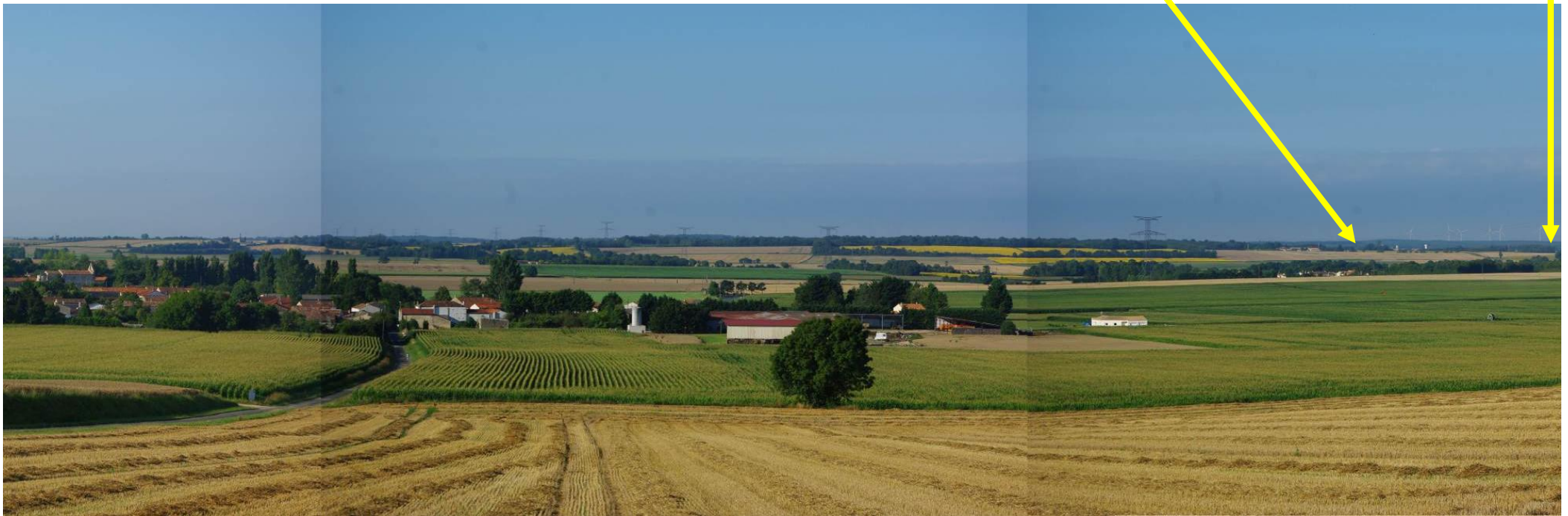
Photographie 5: Vue, depuis Coivert, du site industriel de La Benate avec ses 6 aérogénérateurs.
