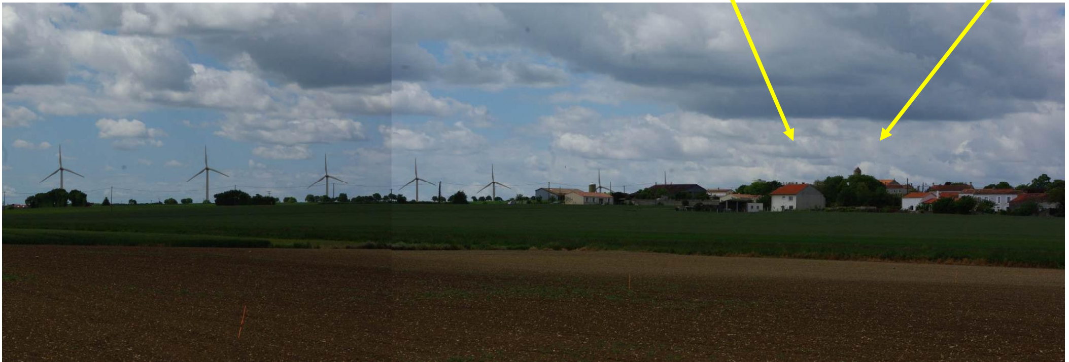
Photomontage 14 : Les 7 machines du parc industriel de Villeneuve la C tsse et Vergné se positionneront à l'ouest de La Croix C tsse , derrière son église..
